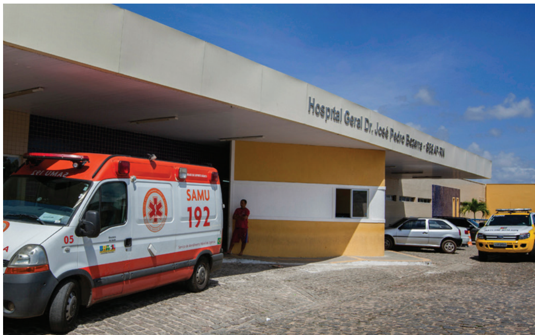
Serão feitas reformas e adequações na ambientação do local, nos banheiros, climatização, além da criação de uma área externa
